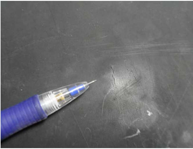
Figura 13. Agrietamiento en la geomembrana de PEAD.
