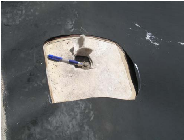
Figura 14. Cuarteamiento de la geomembrana en la zona en contacto con una piedra del soporte.
