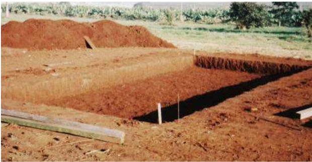
Figura 5. Vista do embutimento do muro no solo de fundação.
